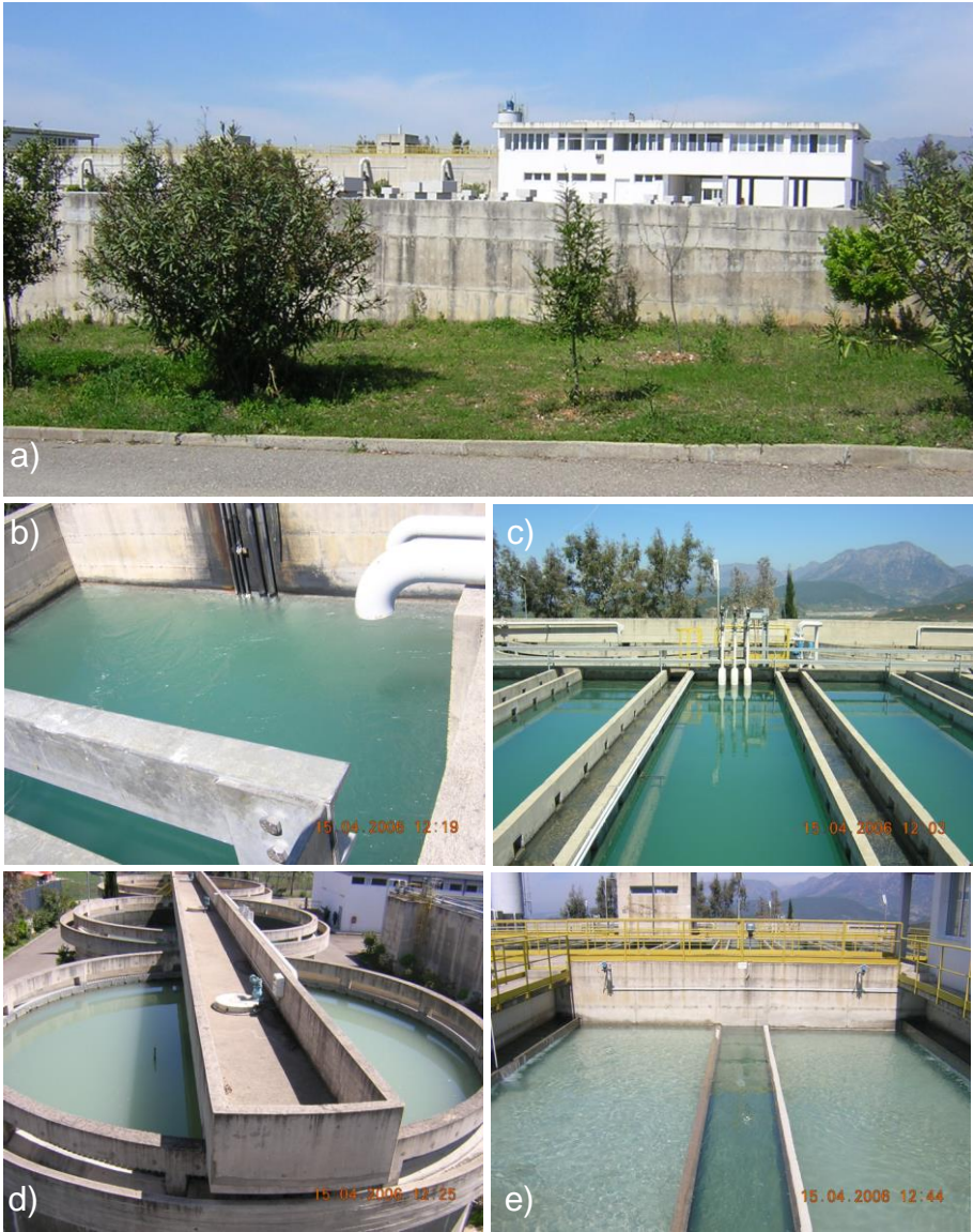
Figura 10-7. a) Pamje nga jashtë e ndërtesës qendrore të Impiantit të Përpunimit të Ujit të Bovillës, Kodra e Kuqe, Tiranë; b) Partitori; c) Flokulatori; d) Dekantuesi; e) Filtri. / a) Outside view of the main buildings of the Bovilla Water Treatment Plant, Kodra e Kuqe, Tirana; b) Partition; c) Flocculation; d) Decantation; e) Filtration (Photos: Buzo & Hoxha).
